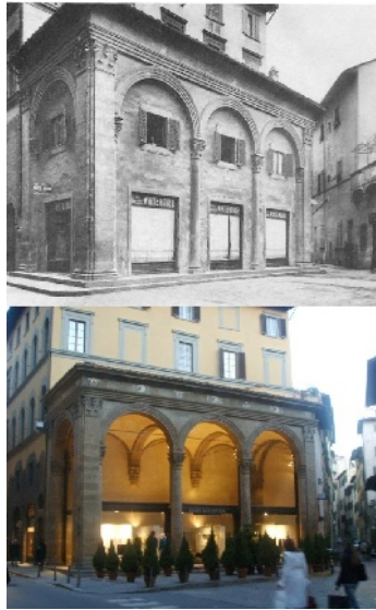
18. L. B. Alberti, Loggia Rucellai , prima e dopo il restauro, Firenze, ca. 1460.
